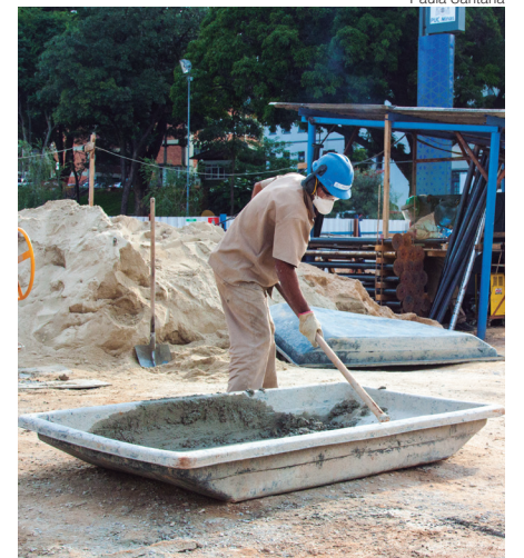
Obras na PUC avançam rapidamente
